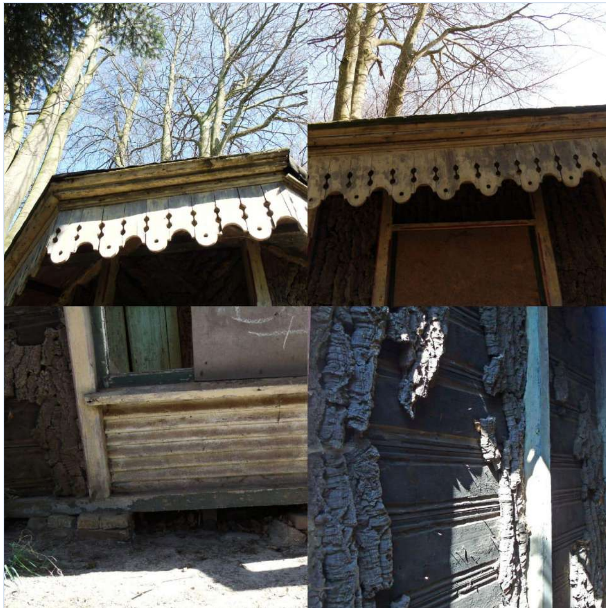
Afb. 18 V.b.n.b. en v.l.n.r.: de gezaagde rand (lichtgeel-crème) langs het dak, de stores onderzijde (eveneens lichtgeel-crème) ramen, de kurkschorsbekleding aan het exterieur, daaronder de vurenhouten rabatdelen
