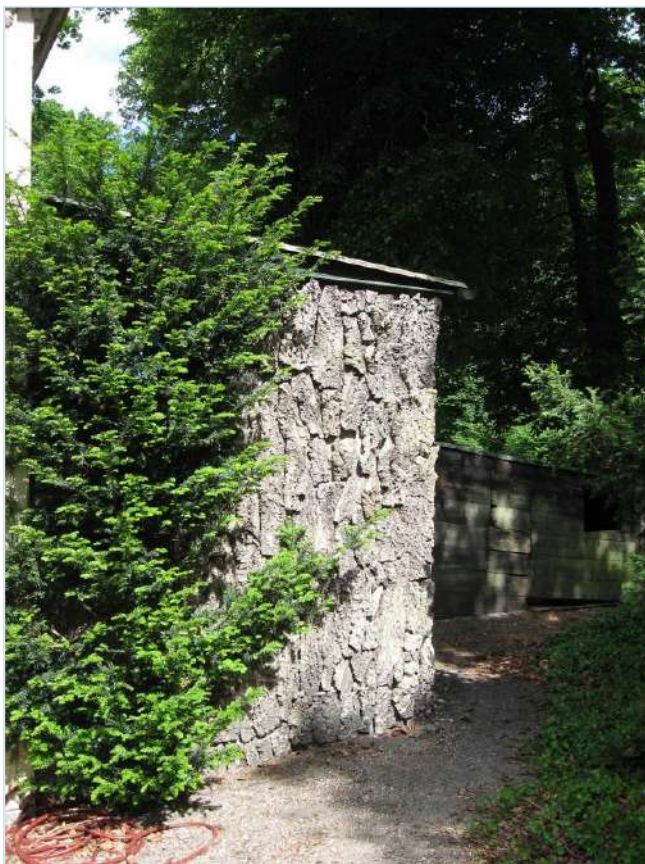
Afb. 4 De aanbouw bekleed met kurkschors op buitenplaats Berbice in Voorschoten in 2011
