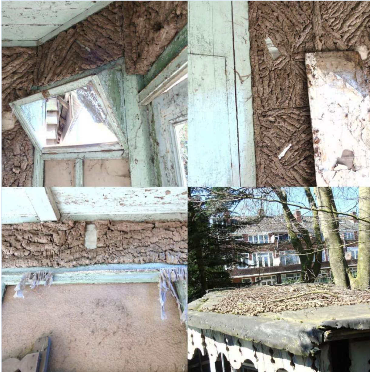
Afb. 17 V.b.n.b., v.l.n.r.: het uitklapraam, een binnenluik, de resten van het gordijntje aan het zijraam (zijde Troelstralaan), hier is de lichtgroene kleur van de binnenzijde goed te zien en het dak
