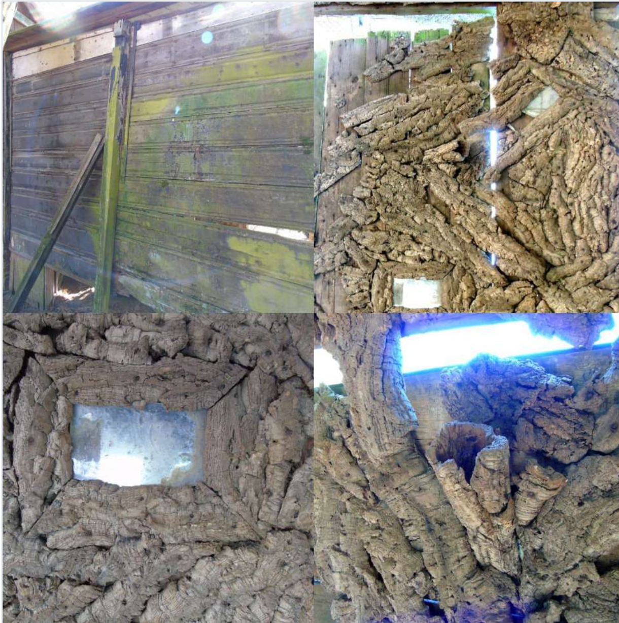
Afb. 19 V.b.n.b. en v.l.n.r.: de achterzijde van het gebouw, zonder decoratie, de kurkschorsbekleding in het interieur, met de spiegeltjes, de spiegel op de achterwand en het wandhoudertje voor planten
