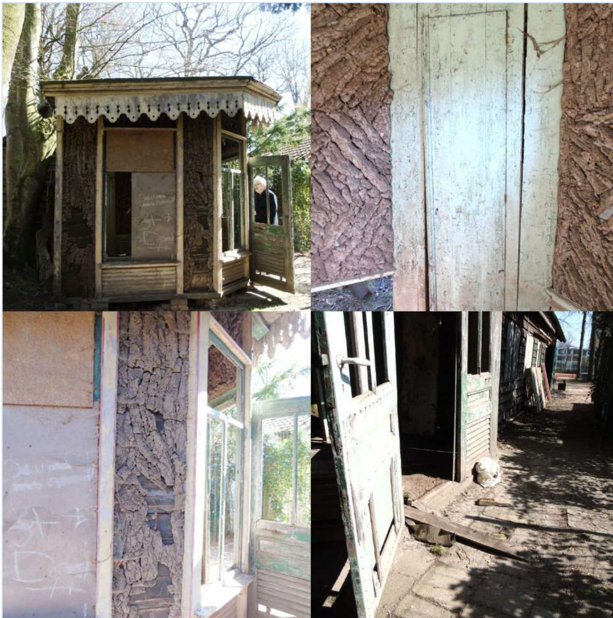
Afb. 15 Van boven naar beneden, van links naar rechts: het paviljoen vanaf de westzijde, de binnenzijde met de hoekkast, de kurkschorsbetimmering aan het exterieur, de dubbele openslaande deuren met stores
